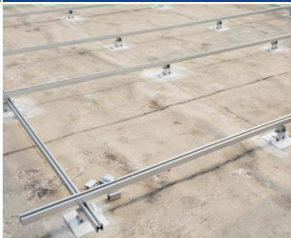
7、Install photovoltaic keel
