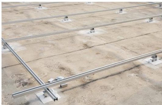
Install frame keel
